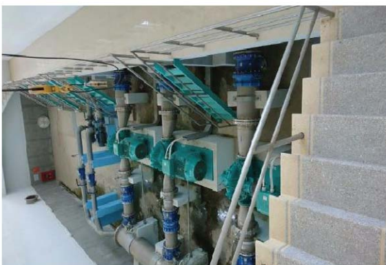
Công trình lắp đặt van cổng, van 1 chiều, van xả khí và mối nối mềm tại Tòa nhà Hòa Phát, 93 Trương Định, Hà Nội
