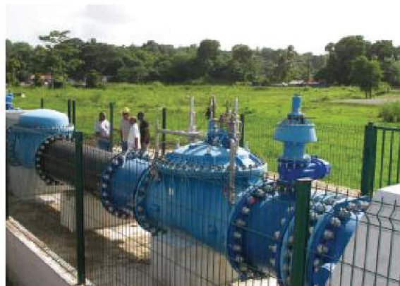
Công trình lắp đặt van giảm áp và quá tốc - DN800 PN25 tại Goyave - Guadeloupe, Pháp
