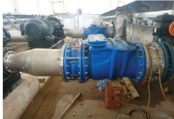
Công trình lắp đặt van bướm, van cổng & van 1 chiều tại Nhà Máy Nước Sạch Giai Đoạn 2 - KCN Vsip Hải Phòng
